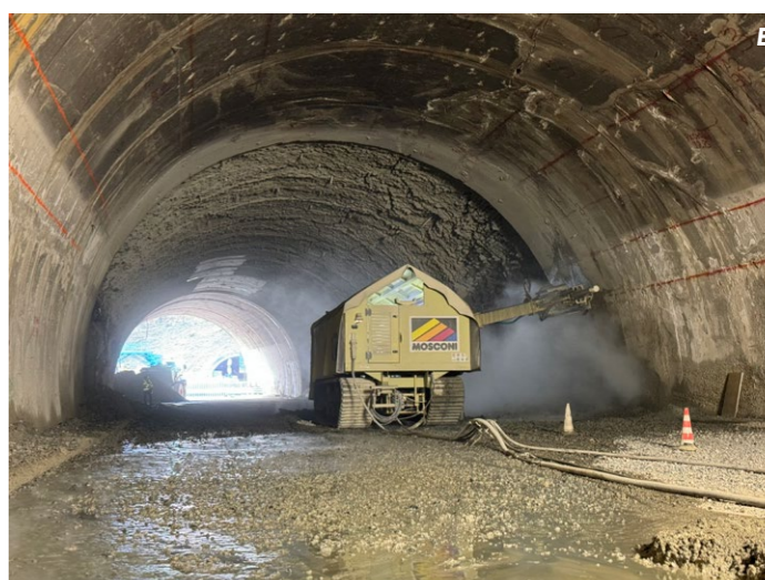
5A e 5B. Il TrackJet 2.0 al lavoro in galleria. Interamente elettrico, ha un'autonomia di movimentazione di 4 km
