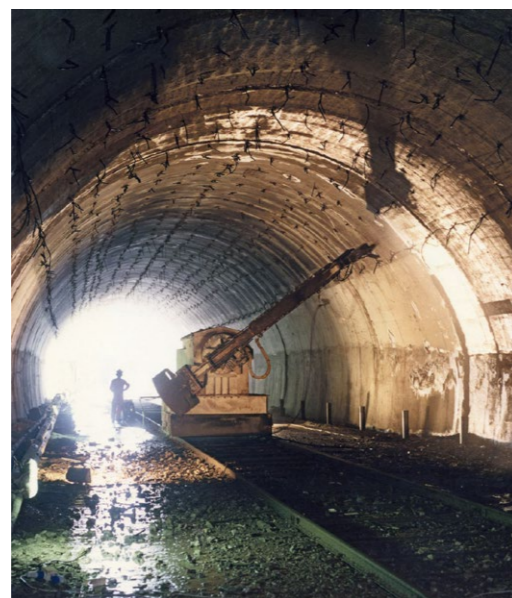
1. Robot per l'idroscarifica al lavoro sull'autostrada A19 in una galleria della tratta Enna-Catania (1991)
