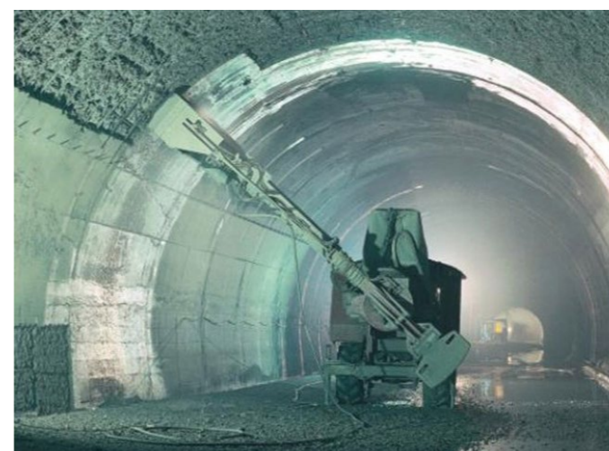
2. Robot da idrodemolizione impegnato nei lavori per la galleria Piedicastello sull'autostrada A22 del Brennero (1998)
